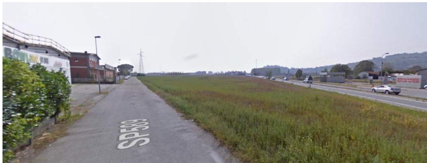
Vista dell'area D13 da nord dalla viabilità interna guardando in direzione di Pinerolo
