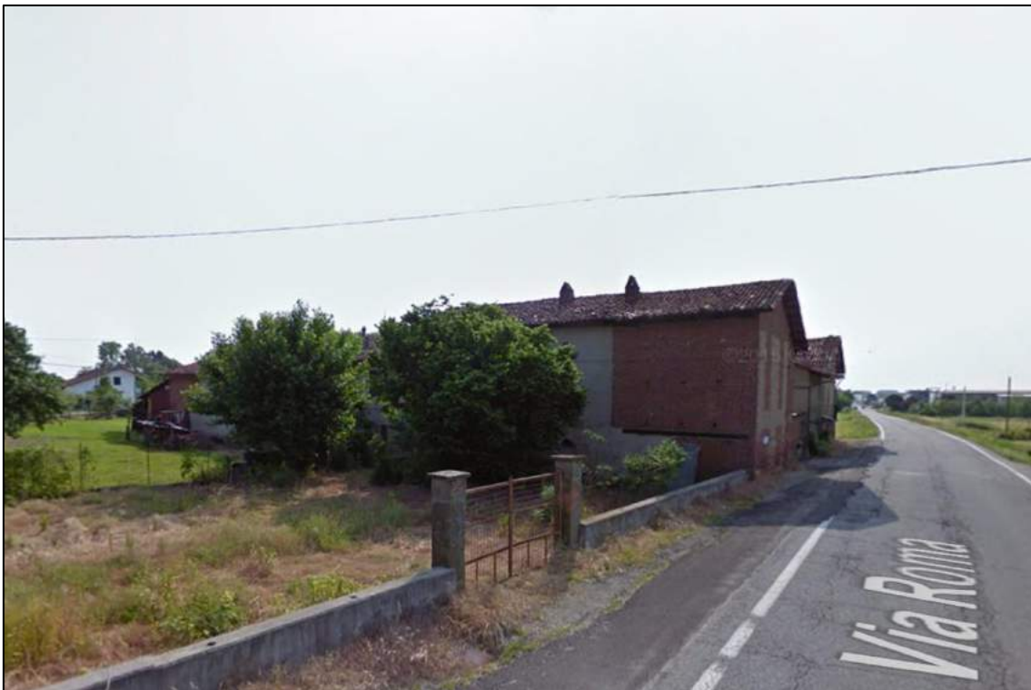
Figura 21 - Cascina localizzata in loc. Tetti, a sud-est del Capoluogo, S.P. 195
