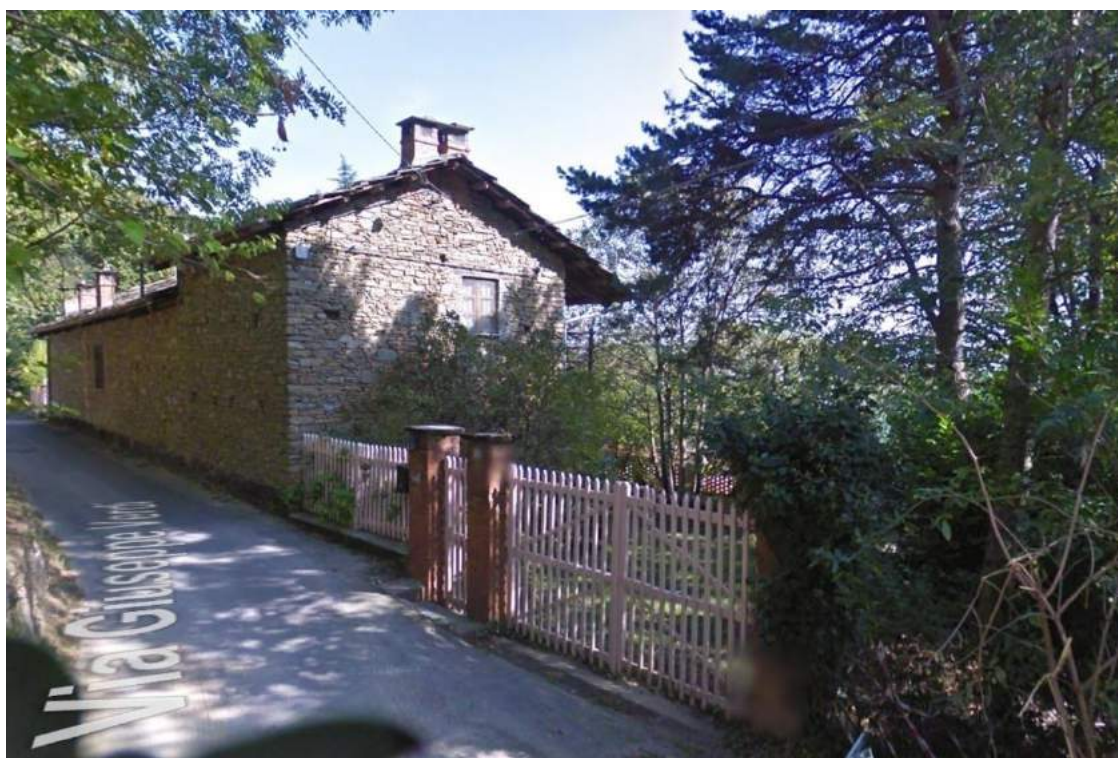
Figura 33 – Cascina in via G. Verdi, n. 42-44, a nord del Capoluogo
