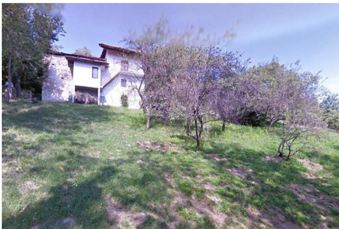
Figura 32 – Cascina Balangero in via Ribetti, a nord del capoluogo
