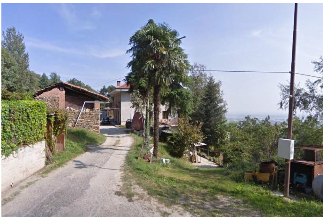
Figura 30 – Cascina in via Bellini, posta a nord del Capoluogo
